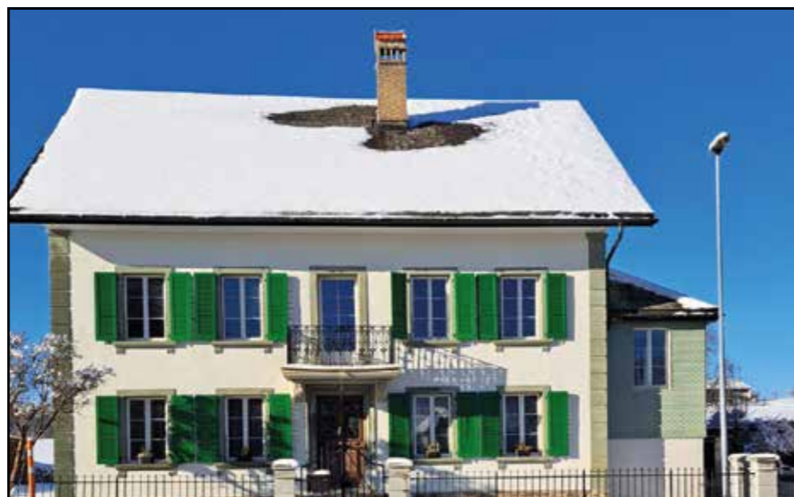
Cure rénovée, Le Crêt
